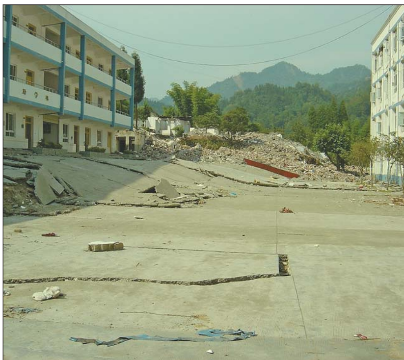
Сейсмический разрыв на поверхности по разлому Пен-Гуань рядом со средней школой.
